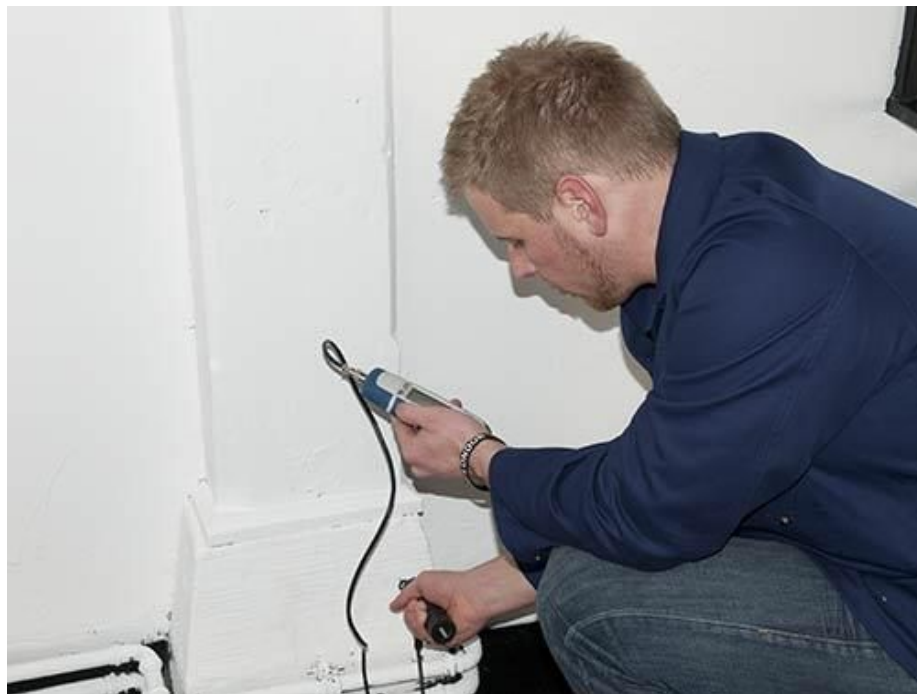
Durch die Messung mit dem Universalfeuchtemesser können Arbeitsschritte geplant werden
