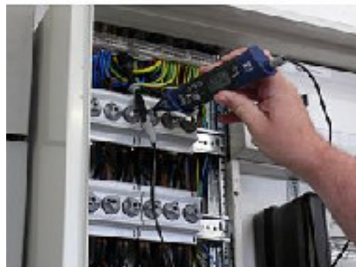
Hier sehen Sie das Stift-Multimeter PCE-PDM1 bei der Sicherungsüberprüfung.
